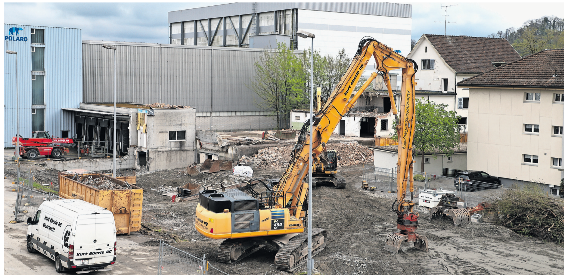
Vom Bahnhof aus gesehen: Hier entstehen mitten im Ort Wohnungen und Gewerberäume.
