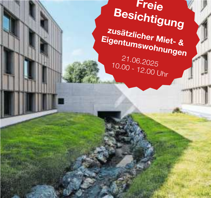
Ein idyllisches Ambiente entsteht durch die Öffnung des Bachs.
