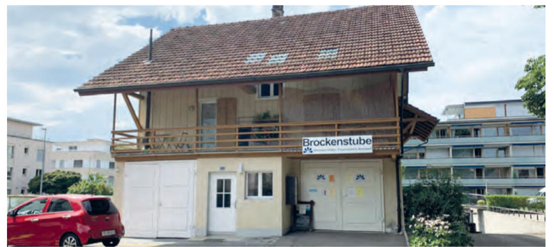
Wo heute die Brocki steht, soll bis Ende 2023 ein Teil der neuen Alterswohnungen realisiert werden.
