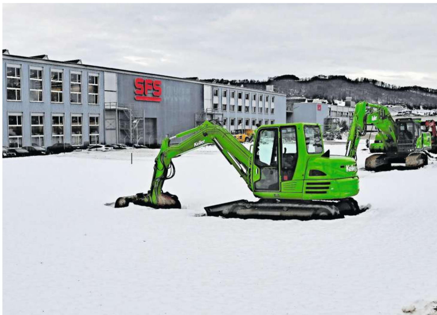
Die Bagger für die neue Produktionshalle von SFS sind aufgefahren.
