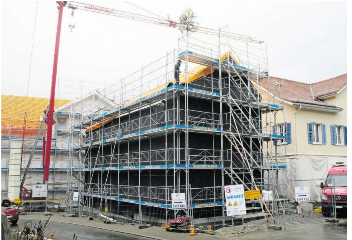
Das Just-Gebäude «Alter Konsum» konnte dieser Tage mit dem Richttännchen geschmückt werden. Links das ebenfalls abgebrochene und wiederaufgebaute «Gründerhaus».
