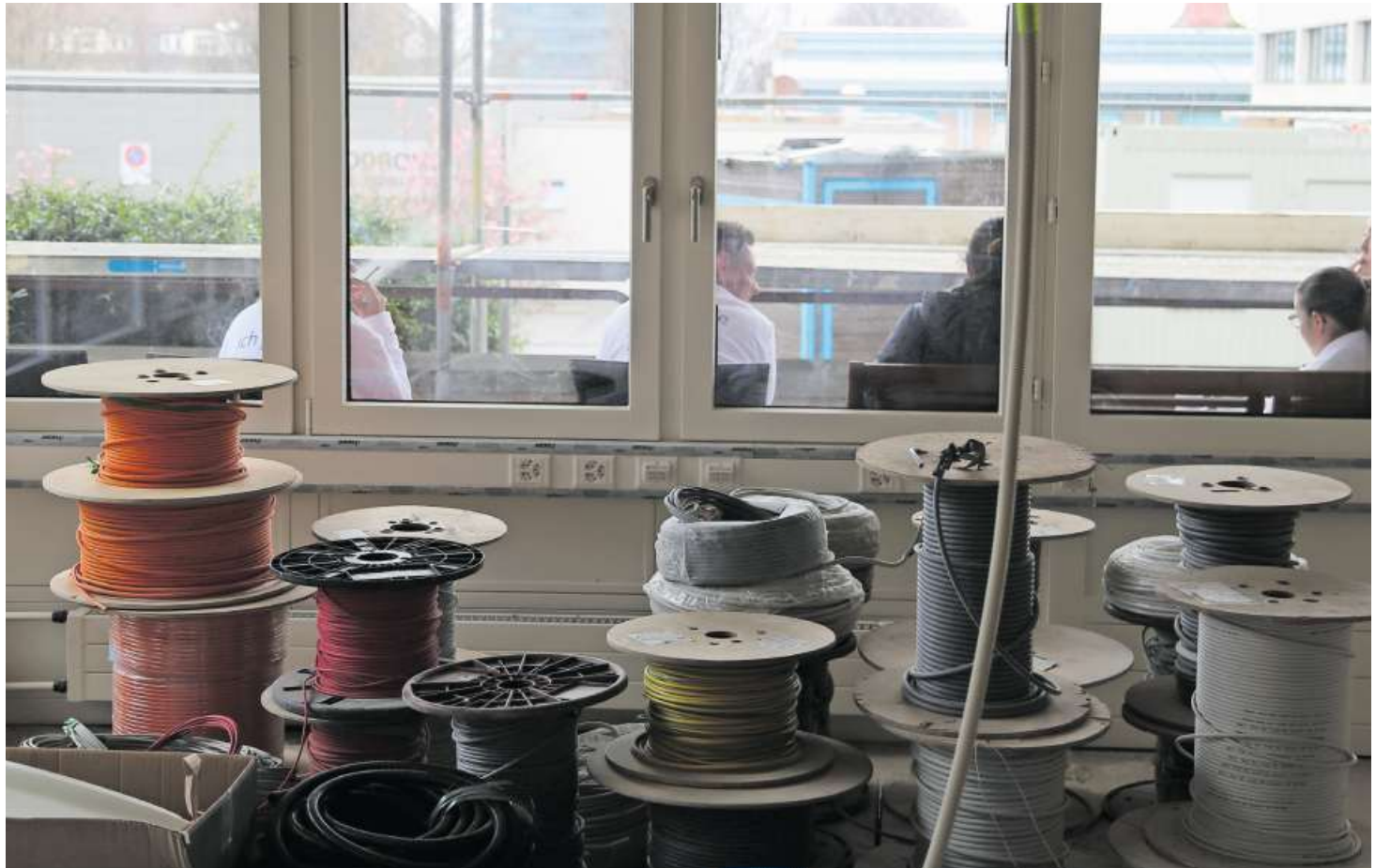
Das Pflegepersonal draussen bei der Rauchpause. Im Vordergrund ein Büro, das derzeit als Kabel-Lager dient.
