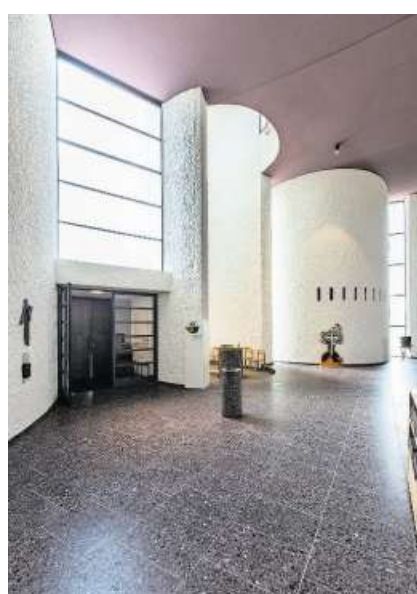
Eingangsbereich mit Terrazzoplatten.
