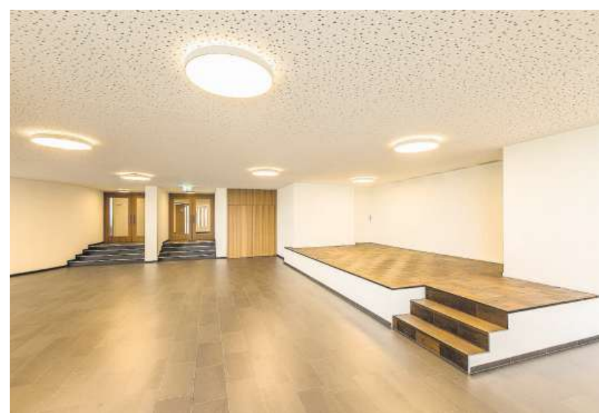
Die bestehende Bühne wurde mit Holz verkleidet.
