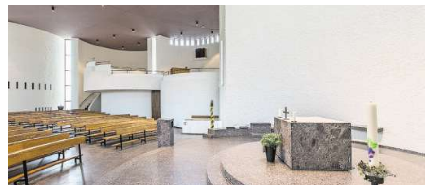
Der Boden, die Wände und die bestehende Möblierung wurden aufgefrischt.
