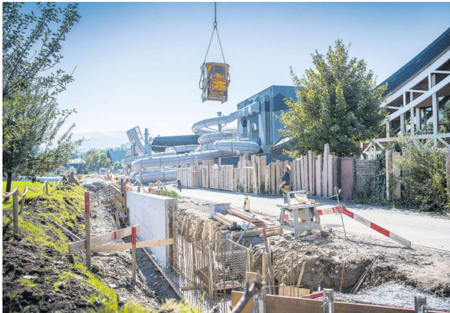
Die Arbeiter bauen die Stützmauern an der Ostseite des Säntisparks. Hierdurch soll das Wasser Richtung Bach fließen.
