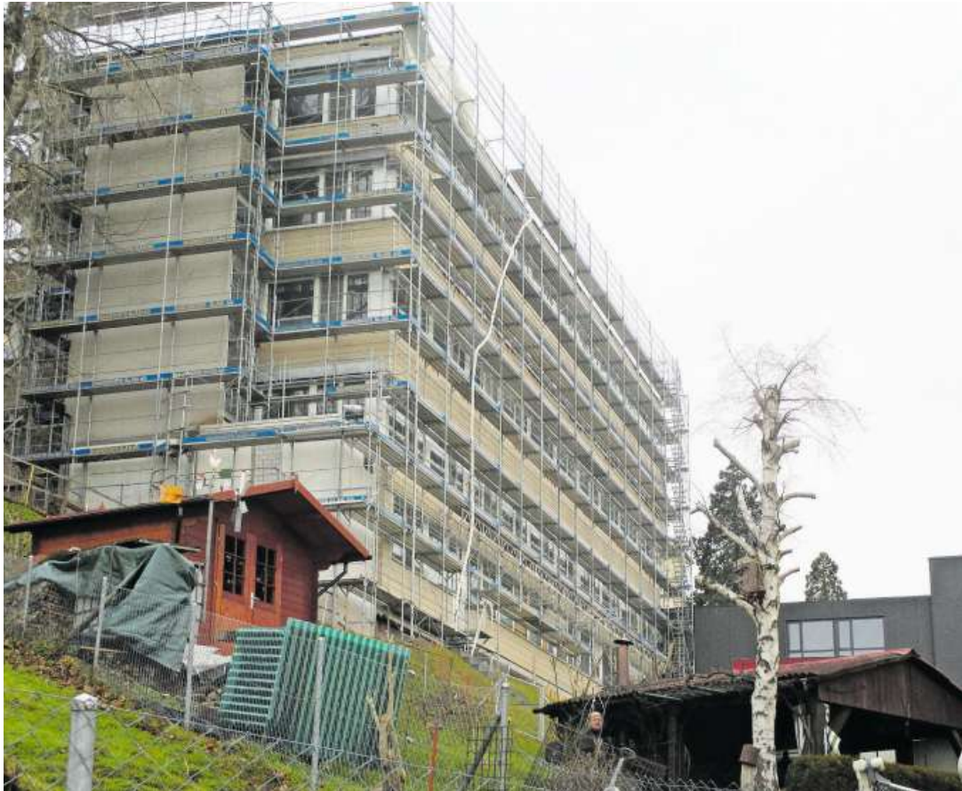
Das alte Fabrikationsgebäude des Familienunternehmens Just AG wird derzeit umfassend saniert. Bild: egb
