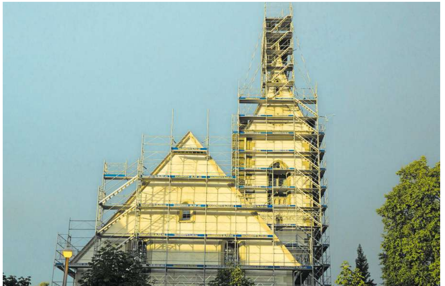
Im Sommer war die Kirche komplett eingerüstet.
