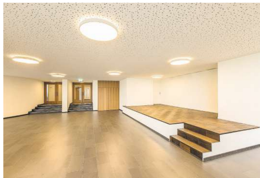
Die bestehende Bühne wurde mit Holz verkleidet.
